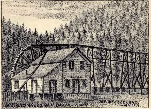
MILFORD MILLS, H.H. DAKIN, PROP'R.
